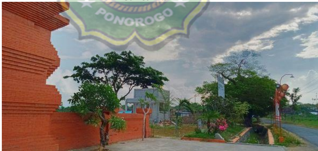
Pembangunan Musholla di Lapangan Desa Prajegan
