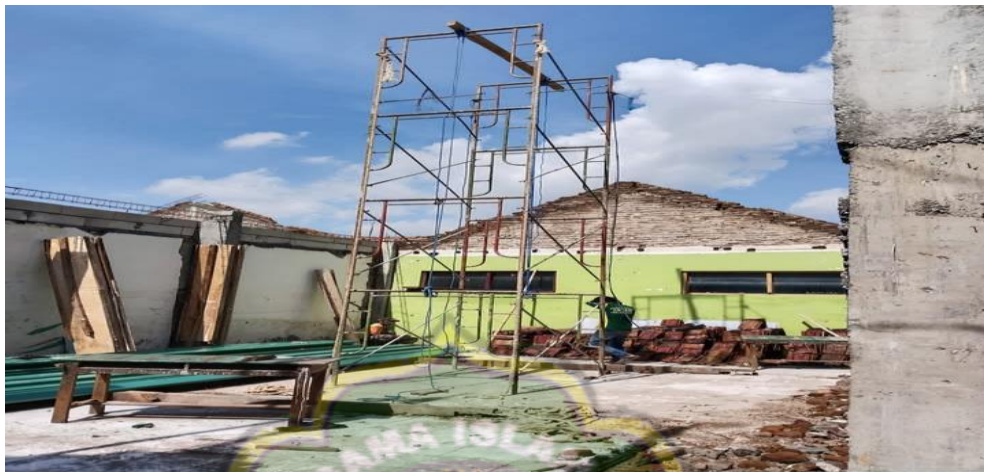
Gambar 4.19 Kondisi Bagian Gedung MI Mambaul Huda
